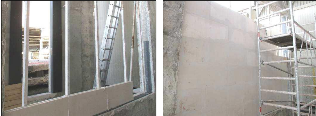
Imágenes 4 y 5 Construcción de la primera hoja de Cerayeso 8
