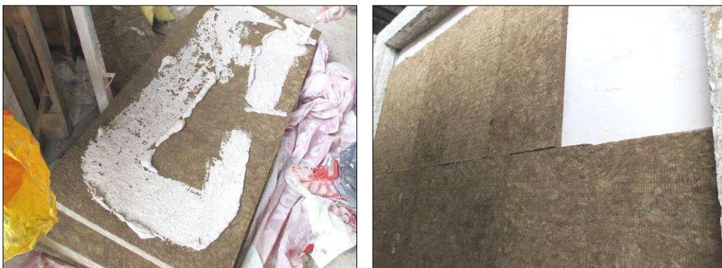
Imágenes 6 y 7 Instalación de los paneles de lana de roca
