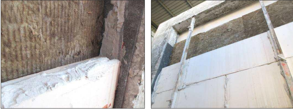
Imágenes 8 y 9 Construcción de la segunda hoja de bloques Cerayes 8
