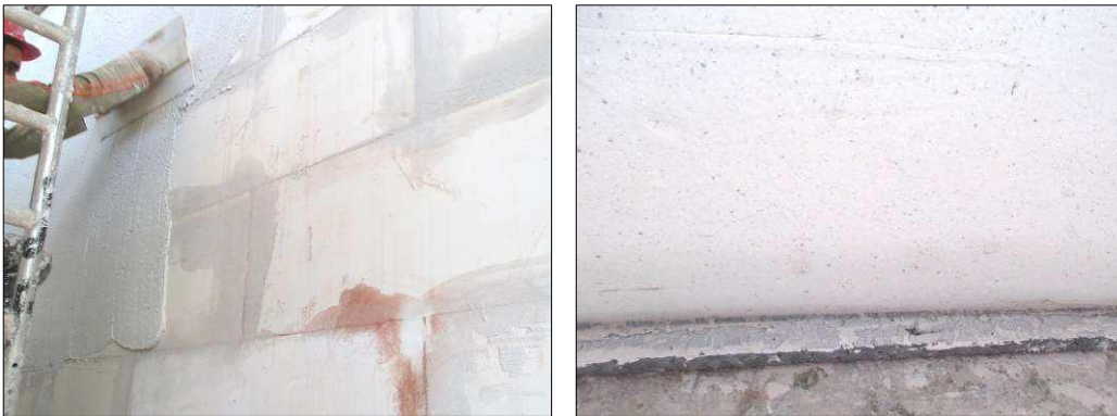
Imágenes 10 y 11 Enlucido del cerramiento y detalle del remate con la banda de EEPS
